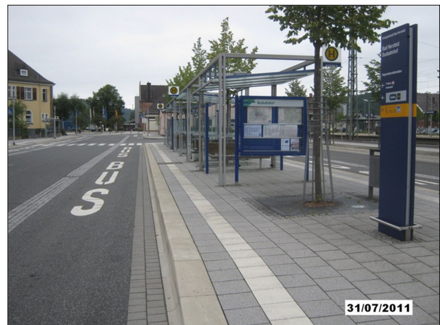
Busbahnhof in Bad Hersfeld (neben Bahnhof)
